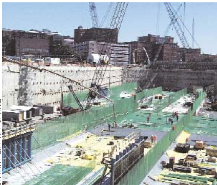
Obras do complexo subterrâneo Big Dig, o maior e mais caro projeto rodoviário dos Estados Unidos, que cruza a região central de Boston
