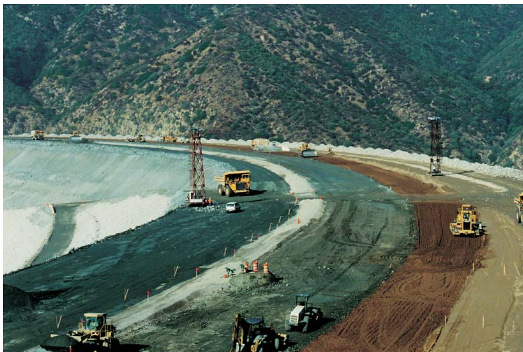
Fig. 2: Praça da barragem com as diversas zonas. O maciço da barragem tem um volume de material de 28 milhões de m 3
