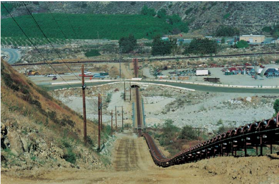
Fig. 4: As correias atravessam vários obstáculos como encostas íngremes e o leito do rio
