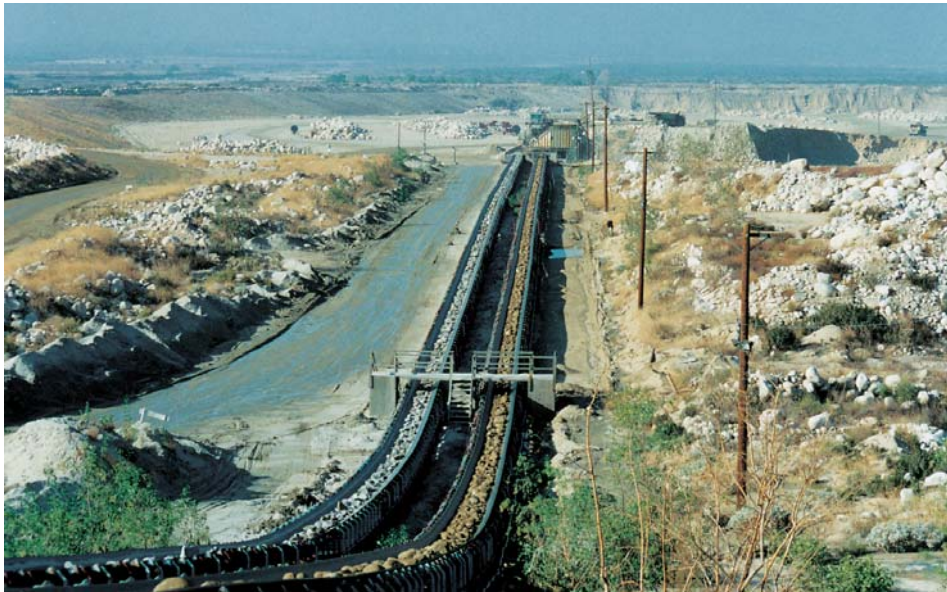
Fig. 3: Os dois sistemas de correias: um transporta material argiloso para o núcleo; o outro, material granular para as demais zonas
